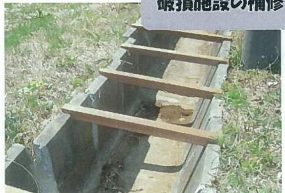
破損施設の補修
