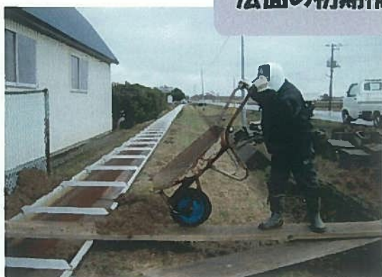
法面の初期補修
